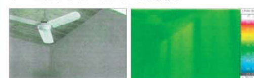
2階リビング天井の内部可視画像です。
